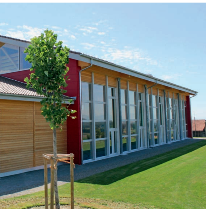
Neben der farblichen Akzentuierung vermittelt die Architektur der neuen Mehrzweckhalle in Kallnach mit konstruktiven und gestalterischen Komponenten – wie der reichlichen Verglasung – den Eindruck von gewollter Transparenz und schlichter Moderne.
