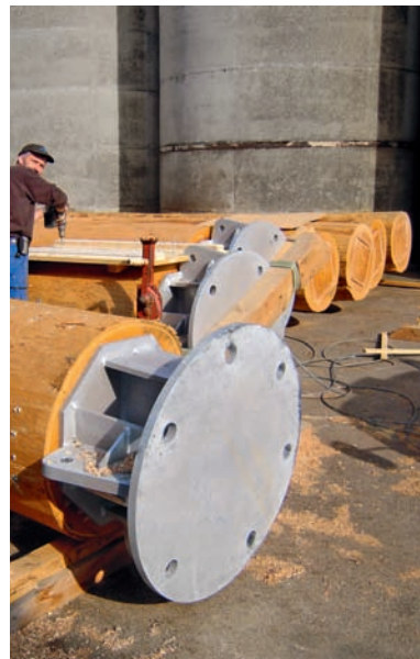
Am Fusspunkt (Ø 900 mm) sind die Rundholzstützen über eine Schlitzblech-Stabdübel-Verbindung und mit einem Stahlteil in Einzelfundamenten verankert.
