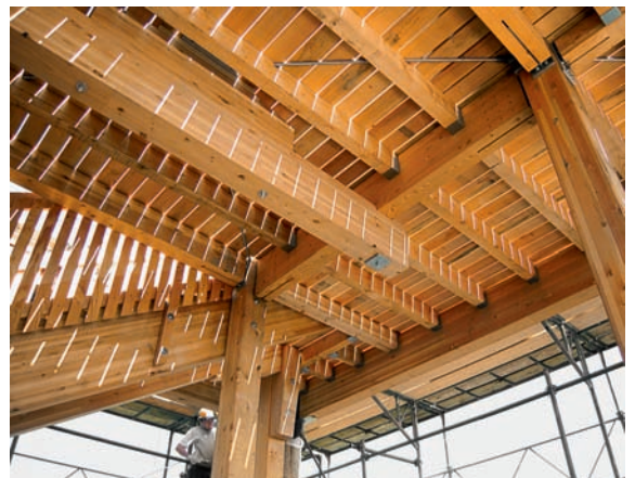
Ein flaches Pyramidendach (oben) schützt die TurmbesucherInnen auf der Aussichtsplattform, deren Unterkonstruktion (unten) mit Brettschichtholz ausgeführt wurde.
