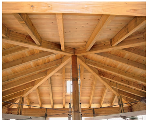
Ein flaches Pyramidendach (oben) schützt die TurmbesucherInnen auf der Aussichtsplattform, deren Unterkonstruktion (unten) mit Brettschichtholz ausgeführt wurde.
