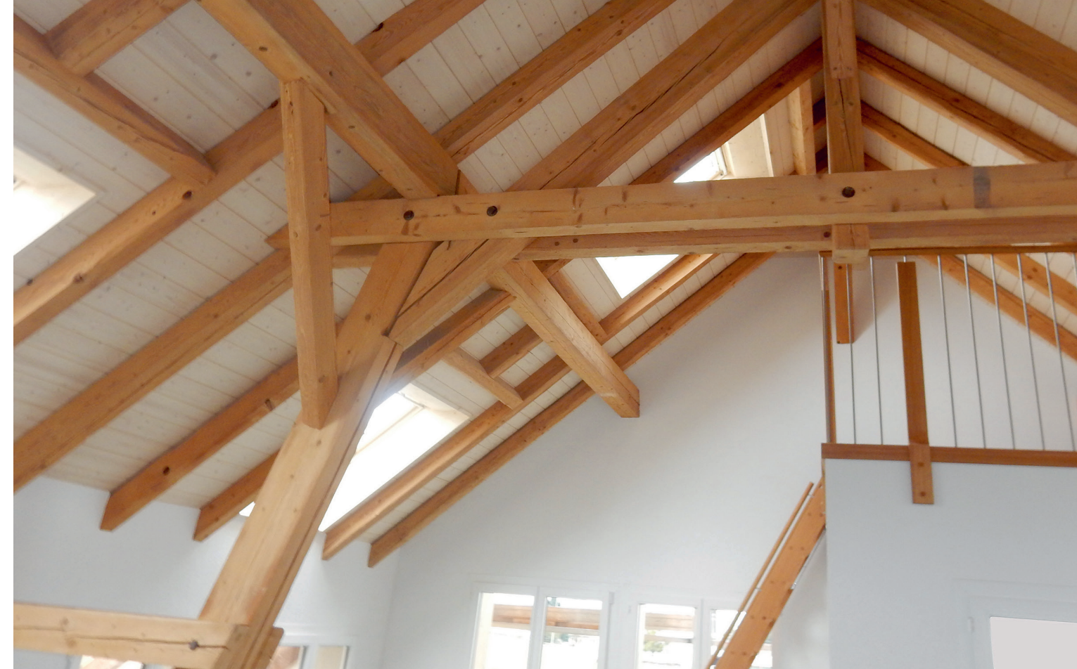
Das Dachtragwerk bleibt bei diesem Umbau eines Bauernhaus in Kerzers (FR) sichtbar.
